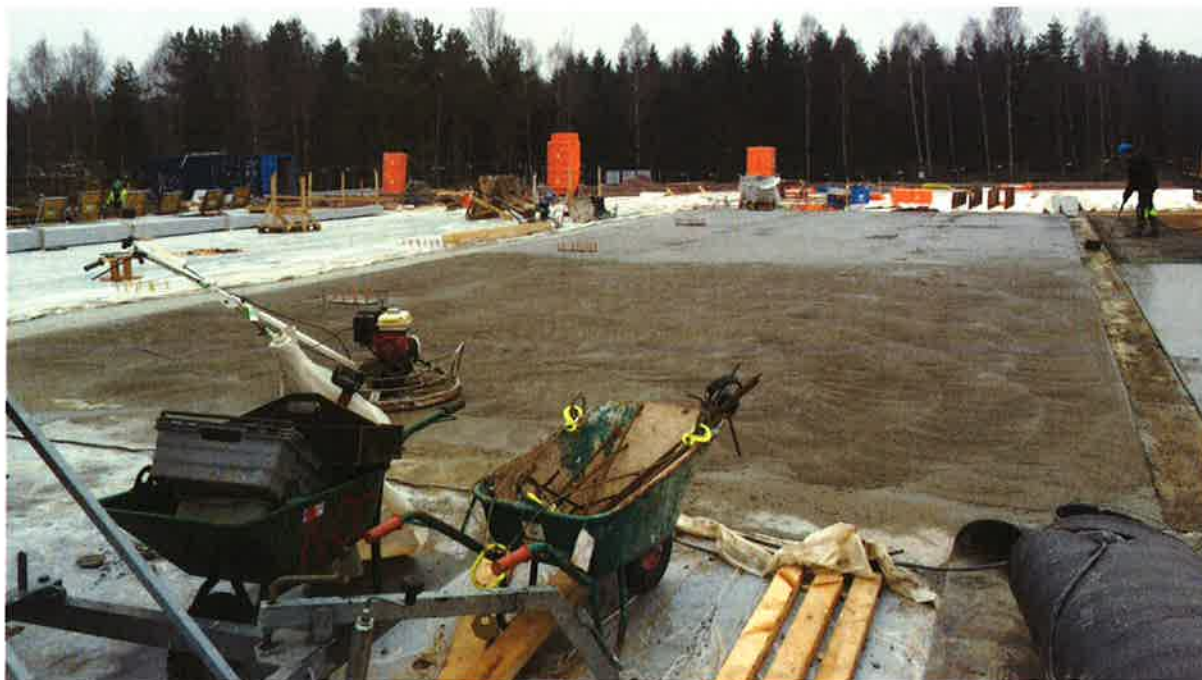
Arbetsytan i samband med gjutarbete 140227
